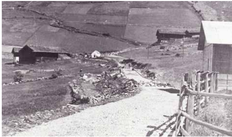
In Bereich der heutigen Ortschaft von Vernagt wird mit dem Bau der Umfahrungsstraße, welche nach Kurzras führt, begonnen; Bild an der Stelle, wo heute das Kirchlein steht.
