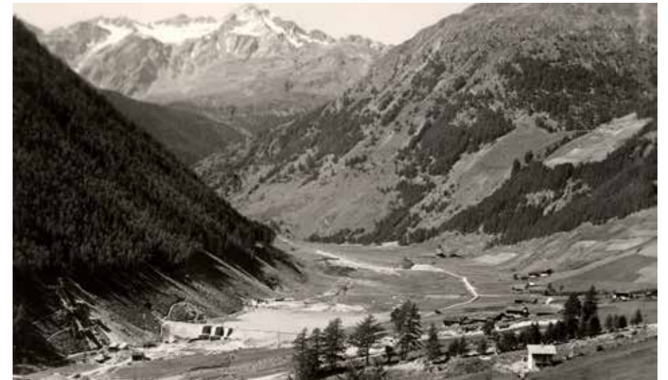
Mit dem Stauseebau in Vernagt hat man 1948 angefangen. Im Bild die Baustelle Anfang der 50er Jahre. Man sieht noch den alten Weg durch die Au in Richtung Kurzras.
