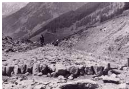
Mit dem Sprengmaterial wurde der Unterbau der Straße hergestellt.
