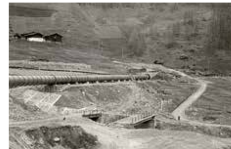
Unterhalb von „Kaser“ wurde in den 50er Jahren die großen Druckrohre verlegt, welche das Seewasser durch das Gebirge ins Pffossental und von dort ins Kraftwerk bei Naturns leiten. Die Rohre wurden später mit Erde zugedeckt und sind heute nicht mehr sichtbar.
