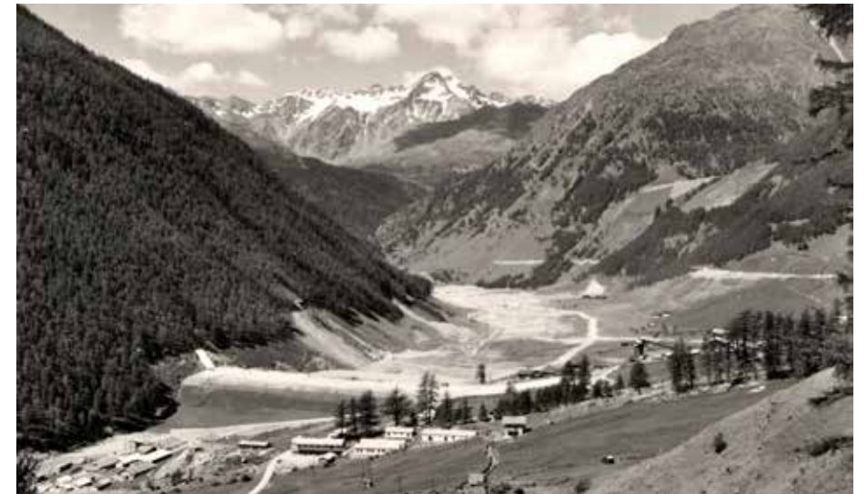
Die Baustelle in Vernagt Mitte der 50er – am Hang sind bereits die Grabarbeiten für die neue Straße nach Kurzras im Gange.
