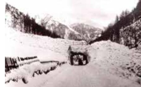
Für kleinere Fahrzeuge wurde ein Schlupfloch (Tunnel) durch die Lawine gegraben. Heute befindet sich an der Stelle ein „richtiger“ Tunnel (Lawinengalerie).
